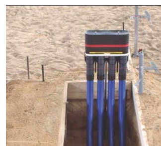
Mehrspartenhauseinführung für Fußbodenmontage
